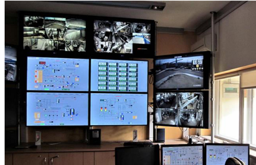
Φώτο: Παράδειγμα συστήματος τηλεχειρισμού της ΔΕΥΑ Κοζάνης
