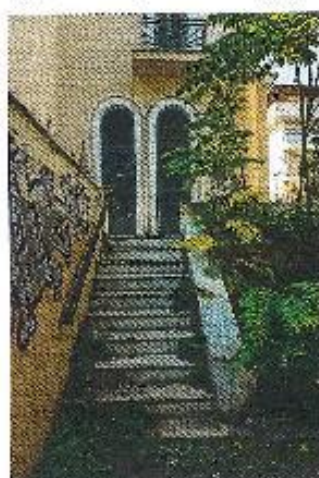
Φωτ.31: Εξωτερική σκάλα με επικάλυψη από μάρμαρο
