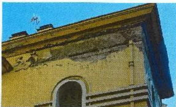
Φωτ.66: Αποκόλληση επιχρίσματος και αποκάλυψη σπλινθών στη βόρεια και δυτική όψη
