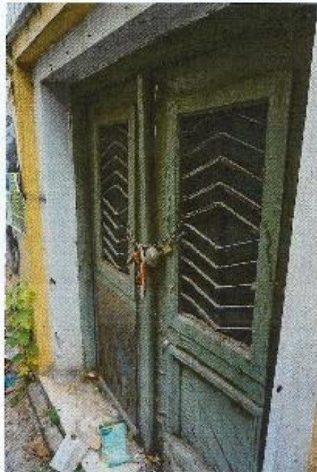
Φωτ.53: Εξωτερικό κούφωμα υπογείου
