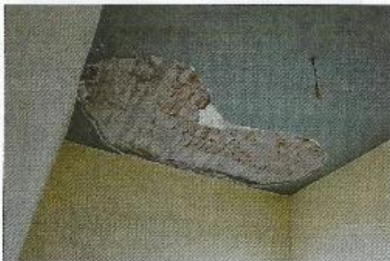
Φωτ.45: Η κατασκευή των πλακών της οροφής ορόφου
