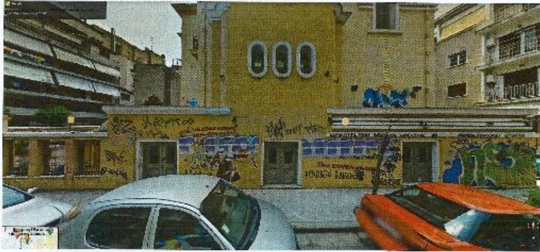
Φωτ.35: Η όψη από την οδό Παλαιστίνης πριν την τοποθέτηση της λαμαρίνας (παλαιότερη λήψη). Πηγή: Google maps.
