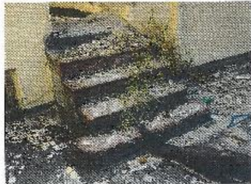
Φωτ.57: Εξωτερική κλίμακα χυτού υλικού κατασκευής
