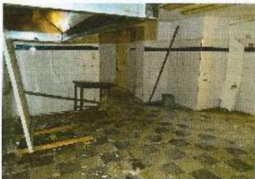
Φωτ.19: Άποψη χώρου υπογείου
