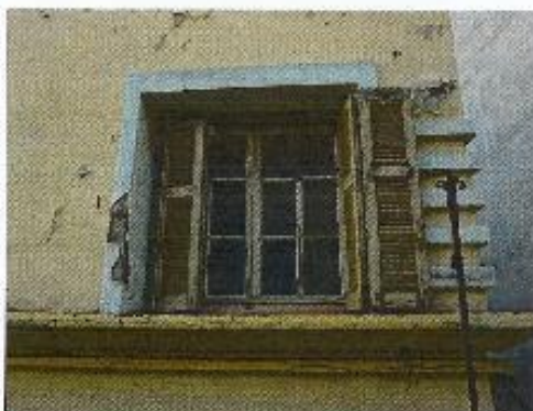
Φωτ.54: Κούφωμα με διακοσμητικό πλαίσιο και ξύλινα περσιδωτά εξώφυλλα γαλλικού τύπου
