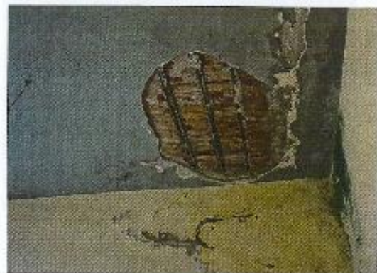
Φωτ.46: Η κατασκευή των πλακών της οροφής ορόφου
