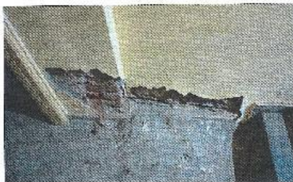
Φωτ.47: Διερευνητική τομή σε τοιχοποιία του υπογείου
