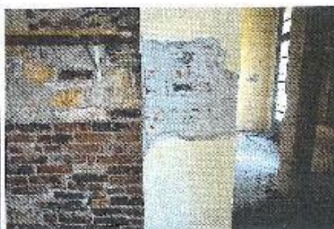
Φωτ.48: Διερευνητική τομή σε τοιχοποιία του ισόγειου
