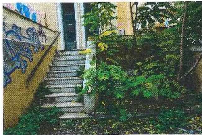
Φωτ.44: Άποψη της μαρμάρινης κλίμακας στον αύλειο χώρο. Τα δύο πρώτα σκαλοπάτια έχουν αποκρυφτεί από τη μεγαλύτερη εξωτερική επίστευση.
