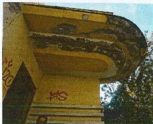
Φωτ.66: Αποκόλληση επιχρίσματος και αποκάλυψη σπλινθών στη βόρεια και δυτική όψη
