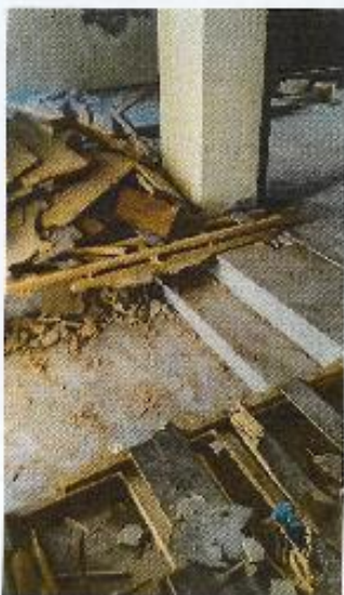
Φωτ.40: Το αρχικό μαρμαρίνο δάπεδο που αποκαλύφθηκε κάτω από το νεώτερο ξύλινο πάτωμα του ισόγειου
