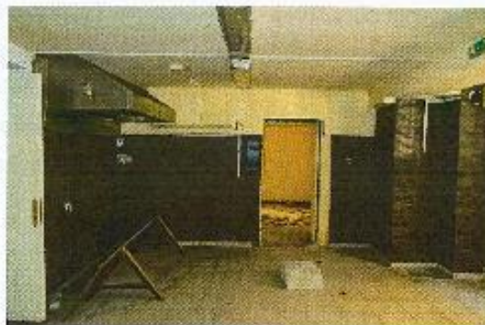
Φωτ.20: Άποψη χώρου υπογείου
