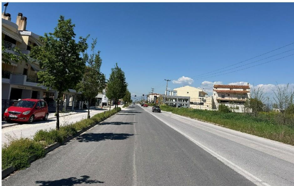
Απουσία ασφαλούς και ανεμπόδιστης όδευσης πεζών
