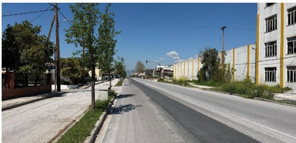
Κατεστραμμένα πεζοδρόμια στα δεξιά και στενά πεζοδρόμια στα αριστερά
