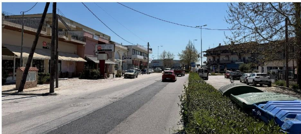
Απουσία κατασκευασμένων πεζοδρομίων και κρασπέδων
