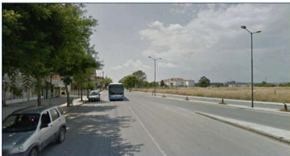
Ανατολικό τμήμα της οδού Καρδίτσας (Πηγή: Google Street View)
