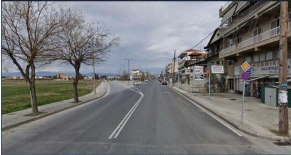
Δυτικό τμήμα της οδού Καρδίτσης-Επαρχιακή Οδός (Πηγή: Google Street View)
