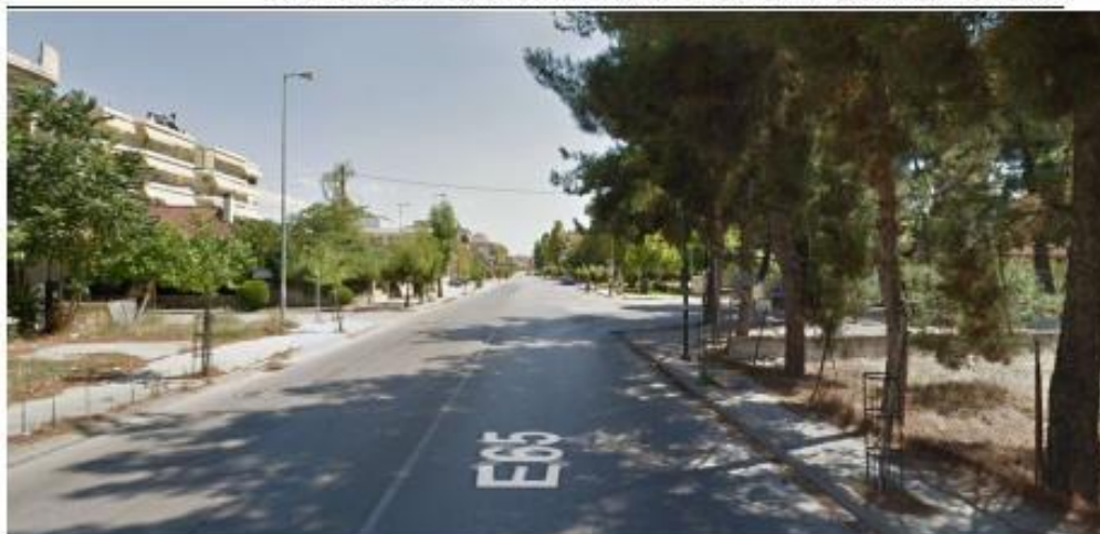
Εικόνα 7. Βόρειο τμήμα της οδού Φαρσάλων, ρεύμα εξόδου (Πηγή: Google Street View)
