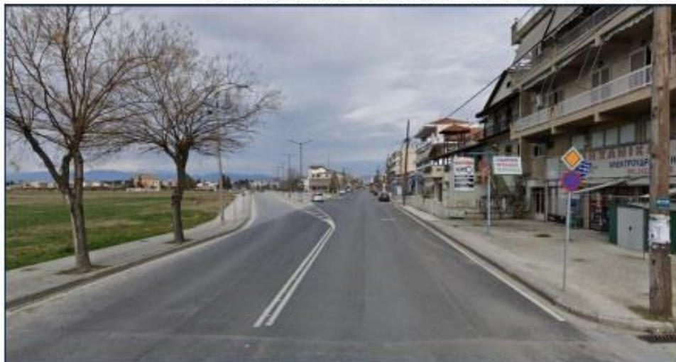
Δυτικό τμήμα της οδού Καρδίτσης-Επαρχιακή Οδός (Πηγή: Google Street View)
